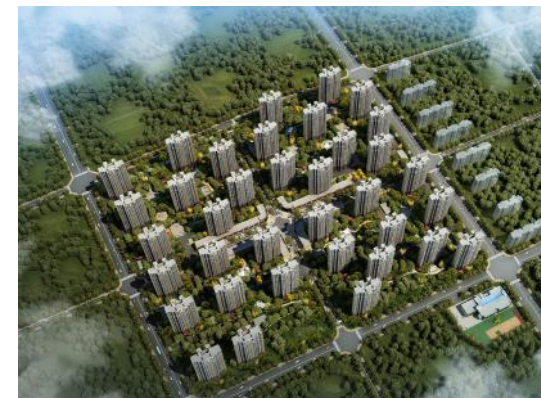
凤凰人家安置房建设工程项目
