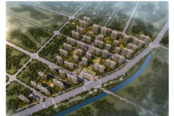
韩桥嘉苑安置房建设工程项目
